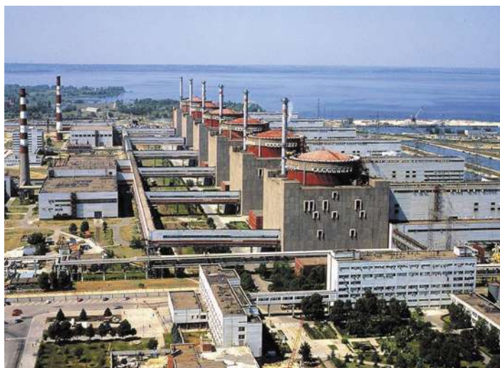
Фото 1. Запорізька атомна електростанція – найпотужніша в Європі
