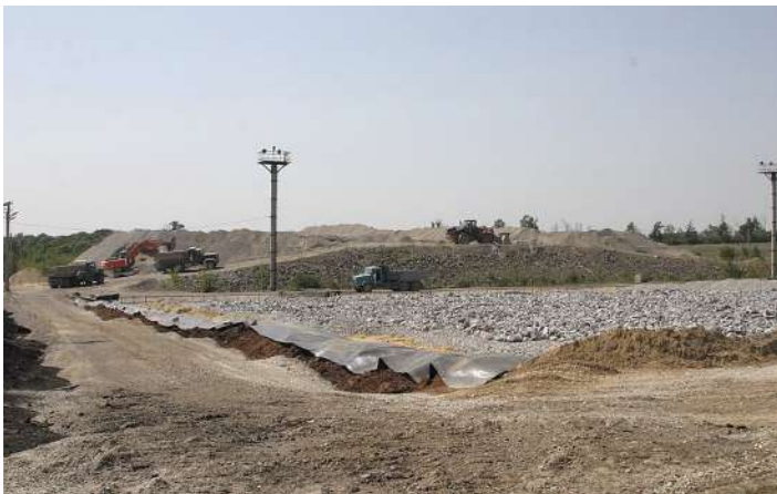
Фото 5. Полігон купного вилуговування Смолінської шахти. Формування нового штабеля
